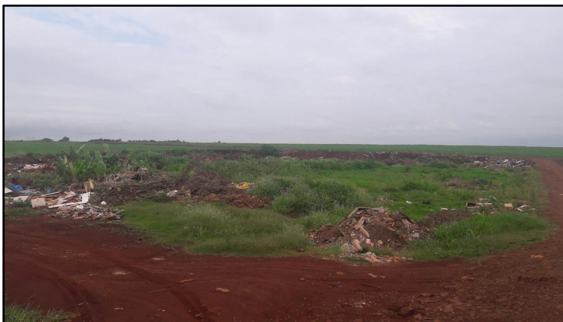
Figura 19: Resíduos da construção civil, volumosos e entulhos dispostos na área de disposição irregular do município de São Pedro do Iguaçu/PR
