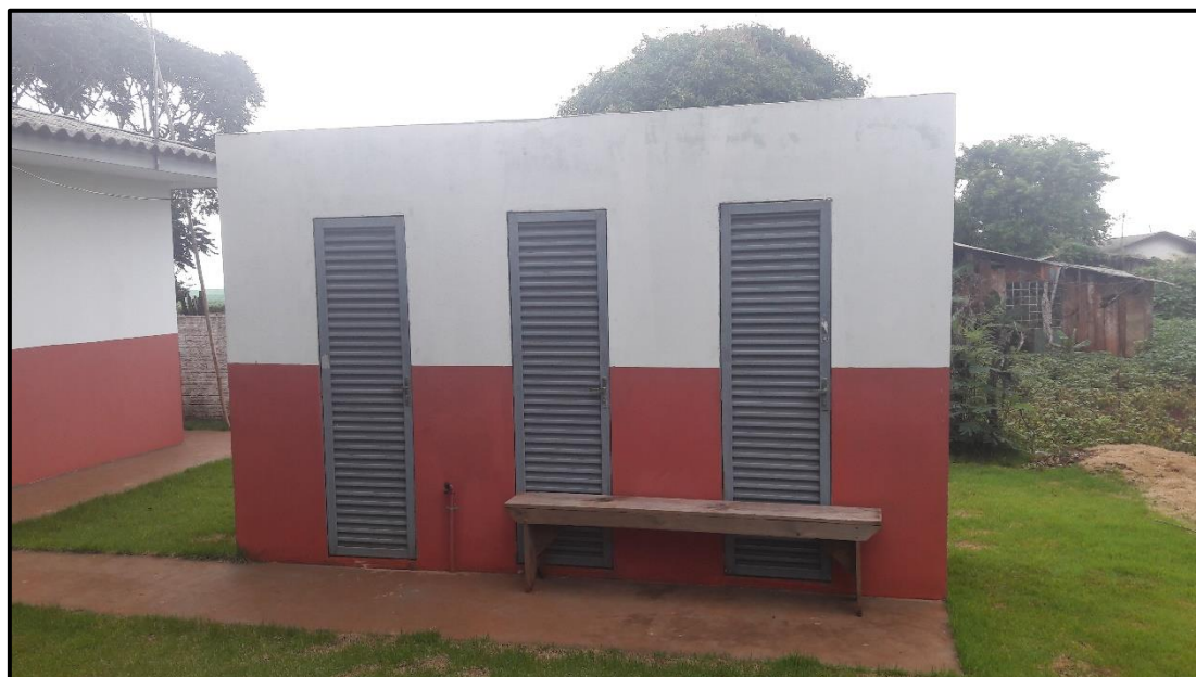
Figura 53: Edificação específica (não utilizada) para o acondicionamento temporário de resíduos dos serviços de saúde da UBS Carolina Paludo Rigo
