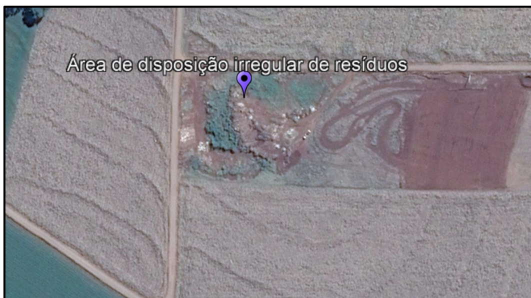
Figura 17: Localização da área de disposição irregular de resíduos da limpeza urbana do município de São Pedro do Iguaçu/PR
