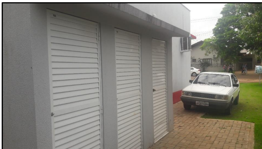
Figura 44: Edificação específica de armazenamento temporário de resíduos dos serviços de saúde da UAP Saúde da Família Moisés Luiz Barreto
