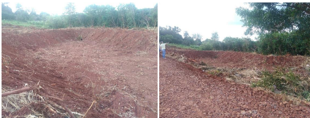
Figura 15 - Lançamento 3 – bacia de detenção.
