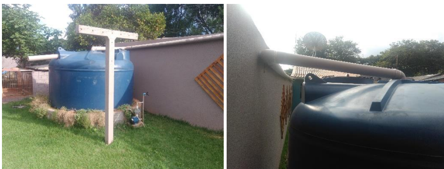
Figura 14 - Aproveitamento de águas pluviais.
