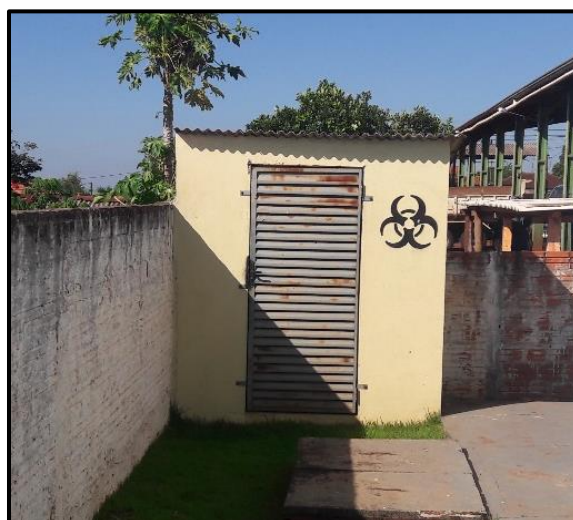
Figura 74: Edificação específica de armazenamento temporário de resíduos dos serviços de saúde da UBS Ouro Verde do Oeste
