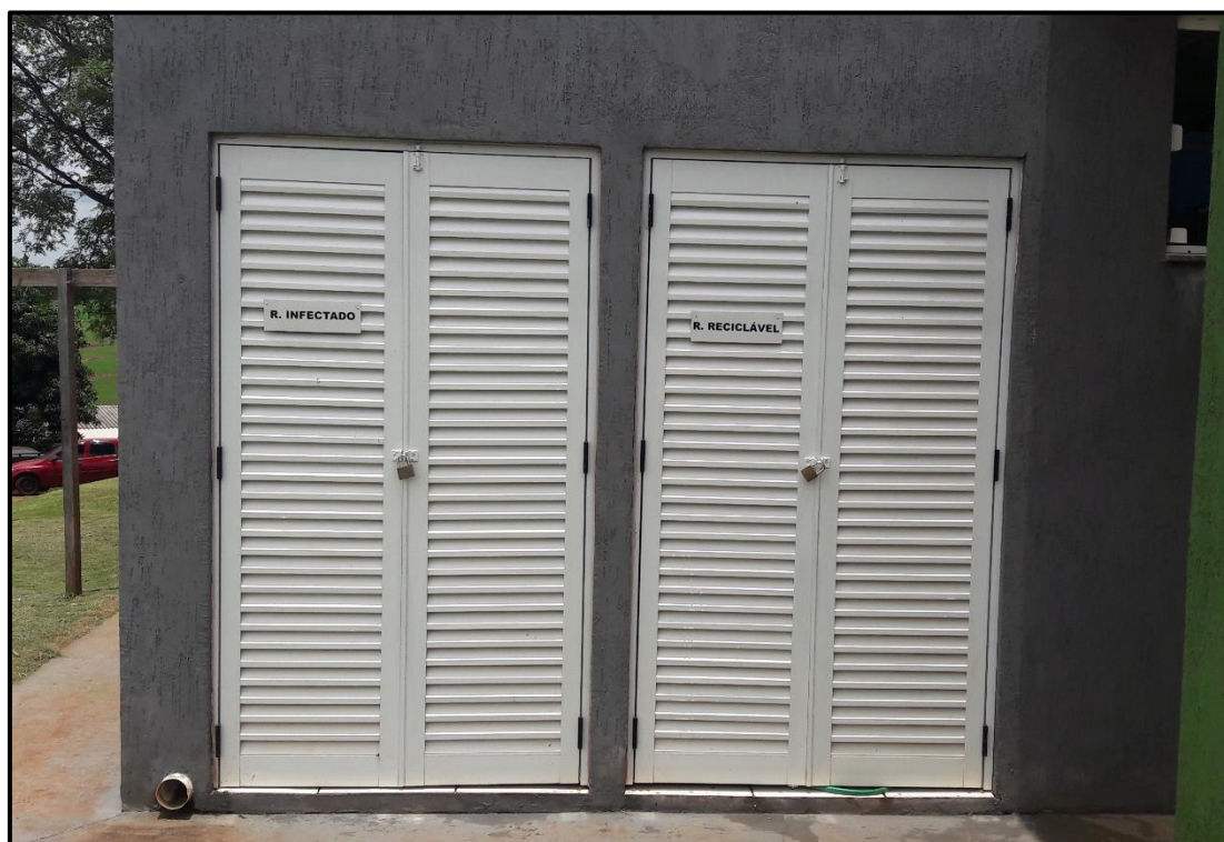
Figura 84: Edificação específica de armazenamento temporário de resíduos dos serviços de saúde da UBS São Sebastião do município de Vera Cruz do Oeste/PR
