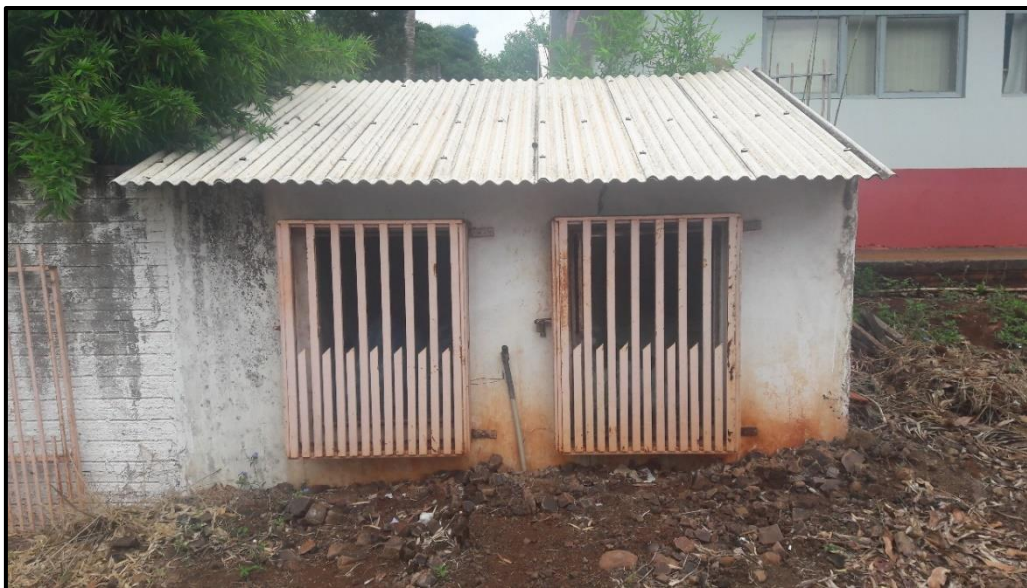
Figura 79: Edificação específica de armazenamento temporário de resíduos dos serviços de saúde da UBS Vereador Arlindo Baccin de São Pedro do Iguaçu/PR
