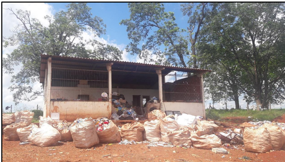
Figura 58: Barracão de triagem de resíduos recicláveis da ACAMAR do município de Ramilândia/PR
