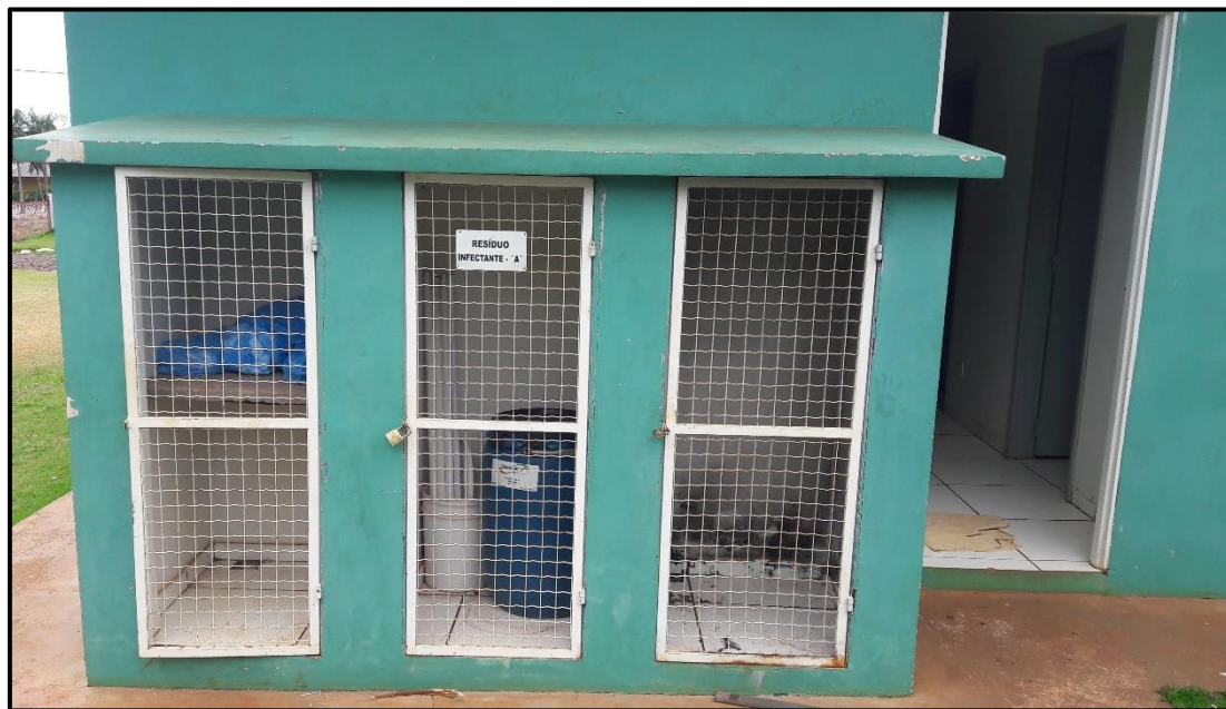
Figura 83: Edificação específica de armazenamento temporário de resíduos dos serviços de saúde da UBS Jardim América do município de Vera Cruz do Oeste/PR
