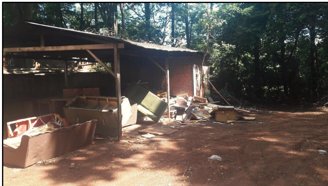
Figura 20: Resíduos volumosos acondicionados em um galpão do Parque de Exposições de Matelândia/PR
