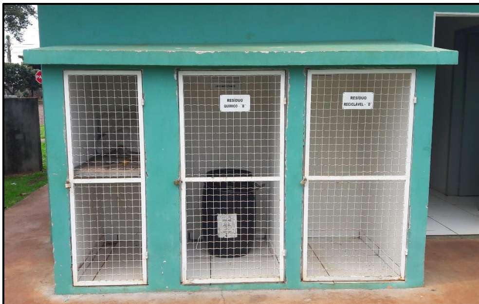
Figura 81: Edificação específica de armazenamento temporário de resíduos dos serviços de saúde da UBS Jardim América do município de Vera Cruz do Oeste/PR
