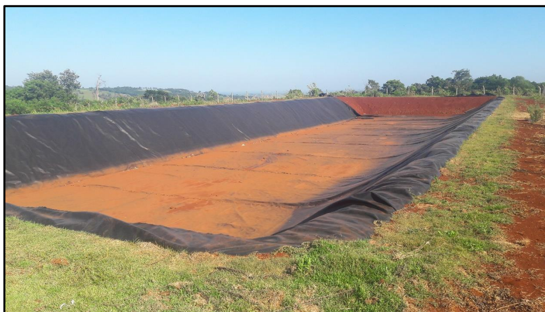
Figura 35: Aterro sanitário municipal de São José das Palmeiras/PR em fase de instalação
