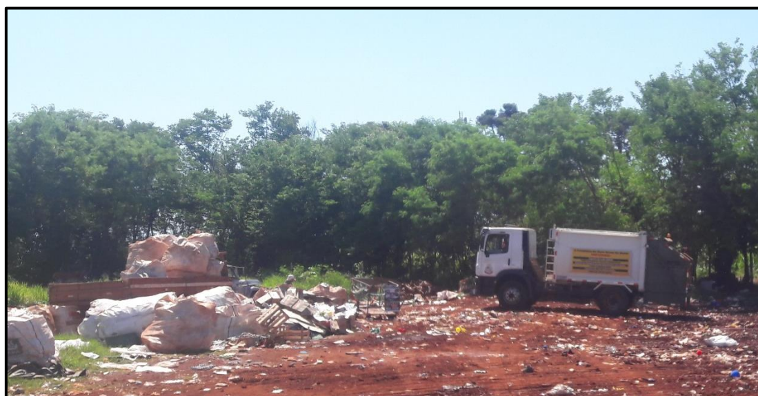
Figura 65: Big bags de acondicionamento de resíduos recicláveis dos catadores autônomos, localizadas no aterro sanitário de Ouro Verde do Oeste/PR
