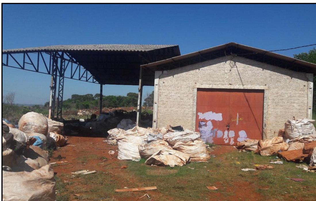
Figura 61: Barracão de triagem de material reciclável do município de Ouro Verde do Oeste/PR
