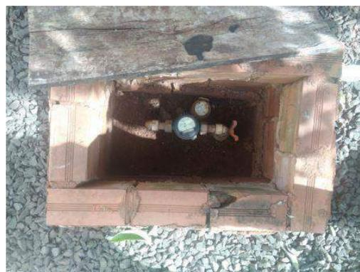
Hidrômetro na saída do reservatório
