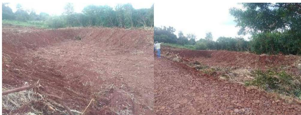
**Figura 82 - Lançamento 3 – bacia de detenção.**
