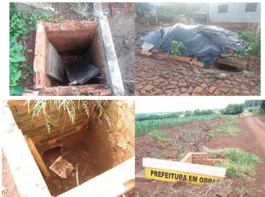
**Figura 44 – Componentes da microdrenagem com problemas de manutenção e limpeza.**
