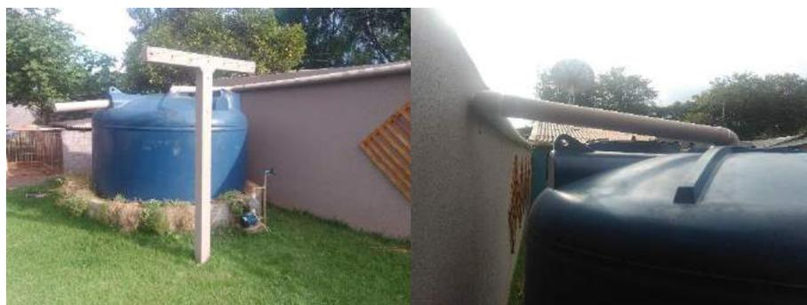
**Figura 54 - Aproveitamento de águas pluviais.**
