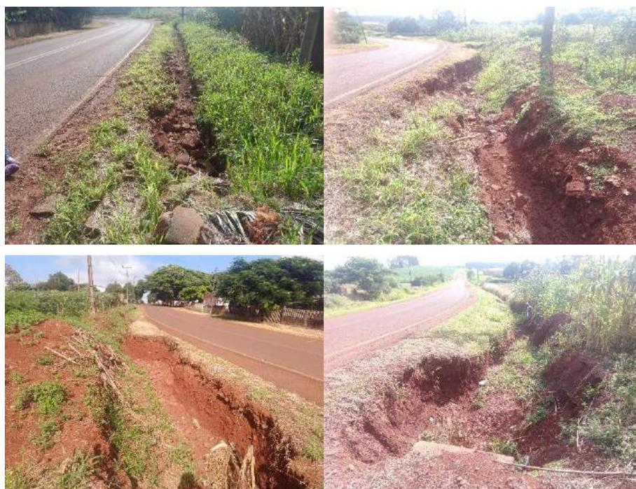
**Figura 60 - Área de risco de erosão – PR 317.**
